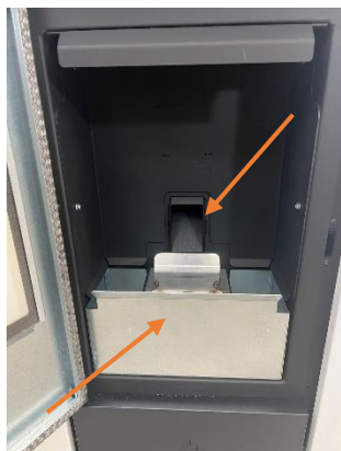
Abbildung 13 – Entfernen der Brennschale und der Ascheschublade
