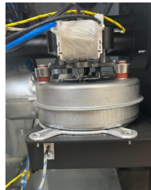
Abbildung 31 - Reinigen der Rauchabgasmotor
