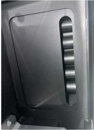
Abbildung 27 - Abgasführung in den Wärmetauschern (Ansicht mit eingesetztem Flammenbrecher)
